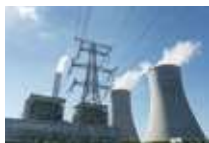
電力プラント
