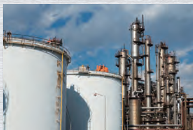
石化工廠 (VCM 廠等)
